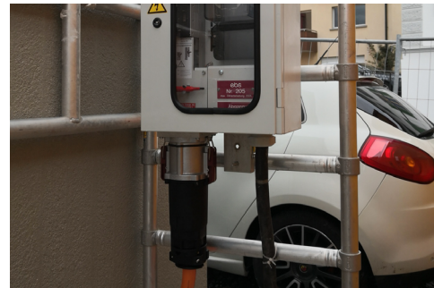
Armoire de distribution pour chantier
