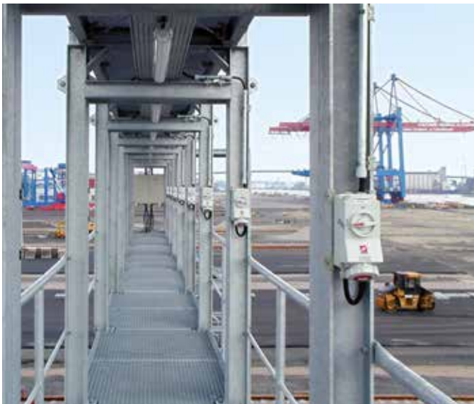
Container Terminal Altenwerder , Duitsland
