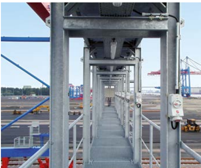
Container Terminal , Altenwerder – Duitsland
